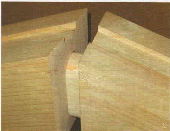
5. Nodo di un diagonale con travi che si innestano alla traditora (archivio De Prà e Legnami Barel, S. Lucia di Piave).
