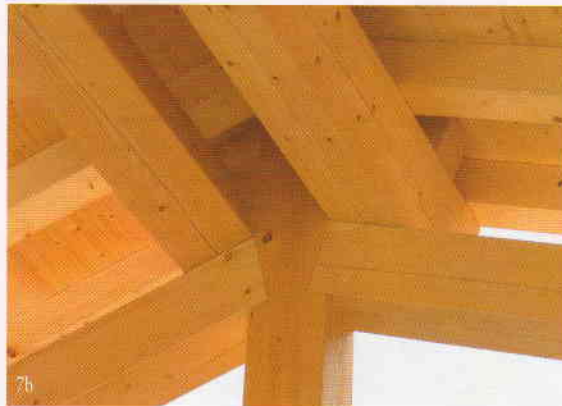
5. Nodo di un diagonale con travi che si innestano alla traditora (archivio De Prà e Legnami Barel, S. Lucia di Piave).
