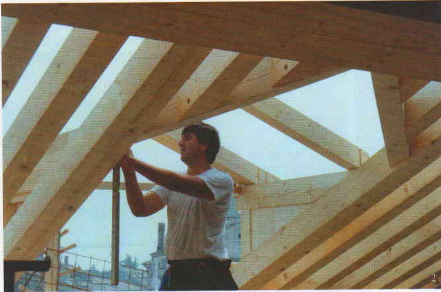
2. Il carpentiere Adriano De Prà al lavoro.
