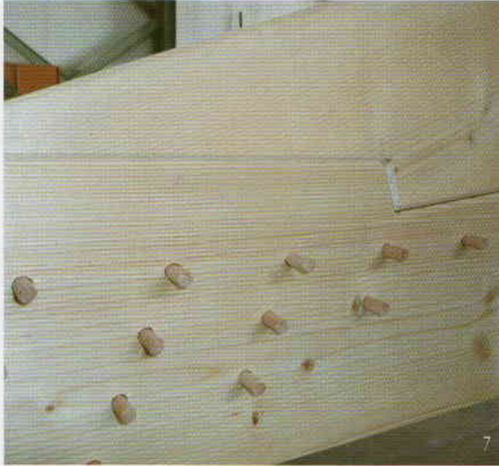
7. Particolare della connessione con cavicchi di 8mm di diametro.
