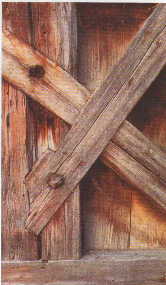
1a e 1b. Cavicchi e barre filettate: l'acciaio è portatore di patologie per il legno.
