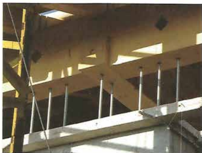
Sollevamento dell'intera copertura di 400mq di una cantina eseguita a pié d'opera e posta in opera in un paio d'ore (Carpenteria De Prà, Treviso)
