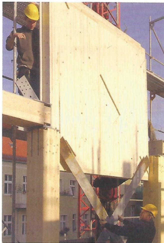
Fase esecutiva di una costruzione multipiano con telai di legno lamellare
