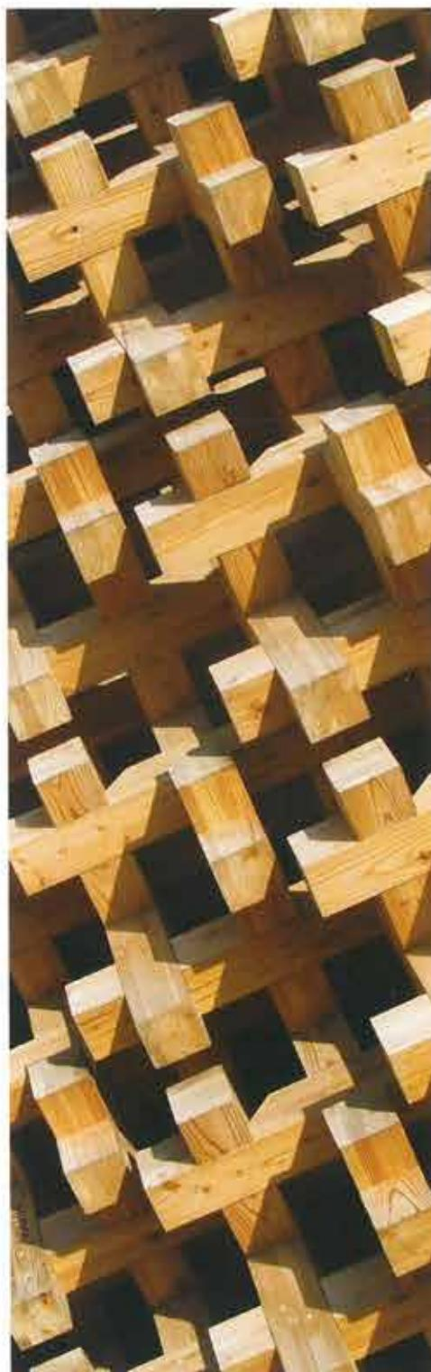
Il giunto Cidori, un vecchio gioco giapponese, un insieme di bastoni di legno con giunti di forma unica, che può essere montato semplicemente ruotando i bastoncini, senza chiodi o raccordi di metallo. Questa architettura è stata utilizzata da Kengo Kuma per la costruzione del padiglione del Giappone per Expo 2015
