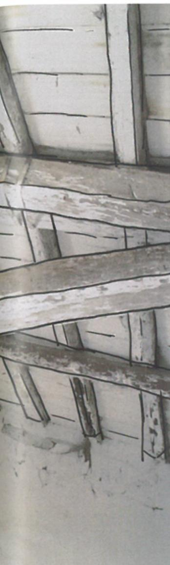
*Nel ritocco: il tetto di un cascinale piemontese. La trave di colmo di sinistra aderisce al monaco della capriata e il fusto su una controcatena avvitata ai puntoni. Una mensolina coadiuva con la controcatena nel sorreggere la trave molto pesante. I falsi puntoni sormontano la trave di colmo, e costituiscono il piano di appoggio per le terzere che formano la falda*
